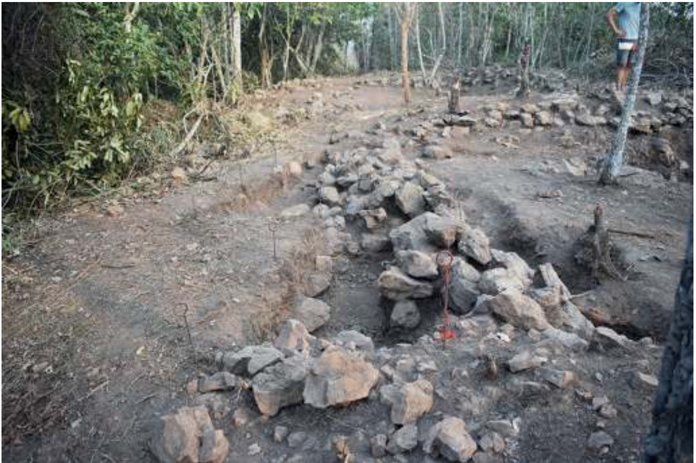
Figura 28. Muro noreste de la estructura 1. Se puede apreciar el colapso del muro hacia el este
